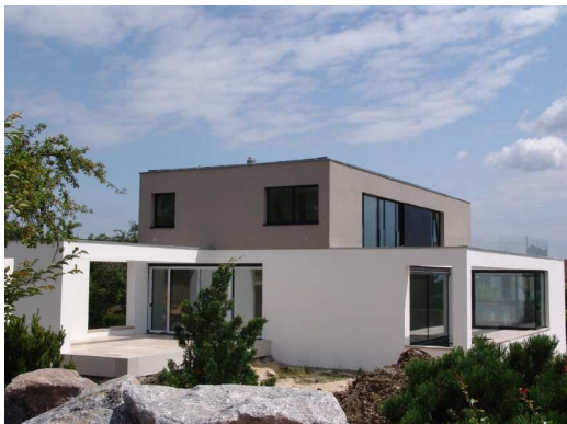
Einfamilienhaus Söflingen: Außenansicht
