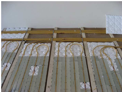
Trockenbau-System im Obergeschoss
