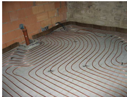
Blanke Kupferrohre für die Gussasphalt-Verlegung im Erdgeschoss
