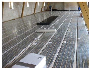
Verlegung des Trockenbau-Systems im Obergeschoss (von links nach rechts)
