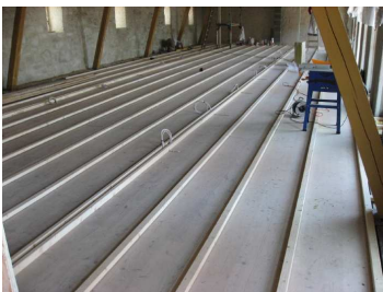
Verlegung des Trockenbau-Systems im Obergeschoss (von links nach rechts)
