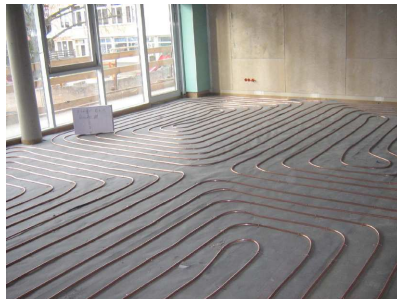
Heizungsrohre in der cuprotherm.blank Ausführung für Gussasphalt
