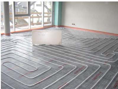
8.300 Meter cuprotherm-Rohre wurden in den Klassenräumen verlegt
